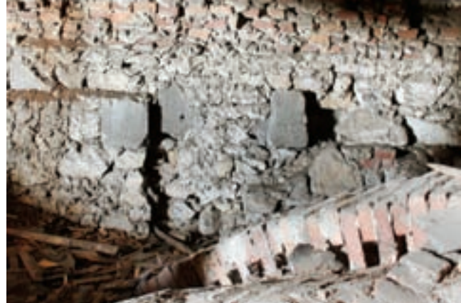
51. Befalazott faragványok a padlástérben
