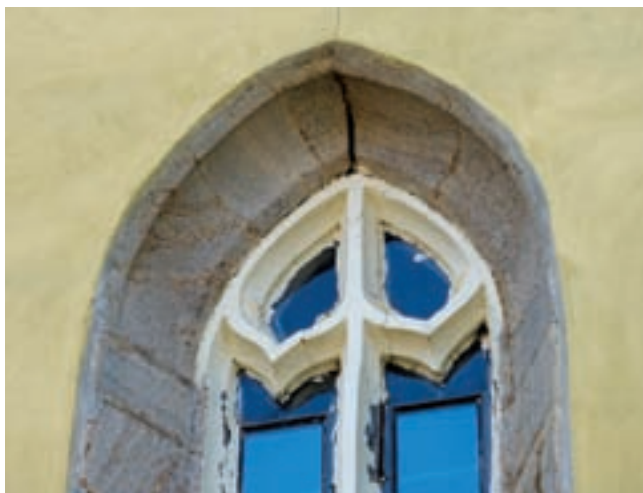
16. Mérmű a szentély északkeleti falszakaszán
