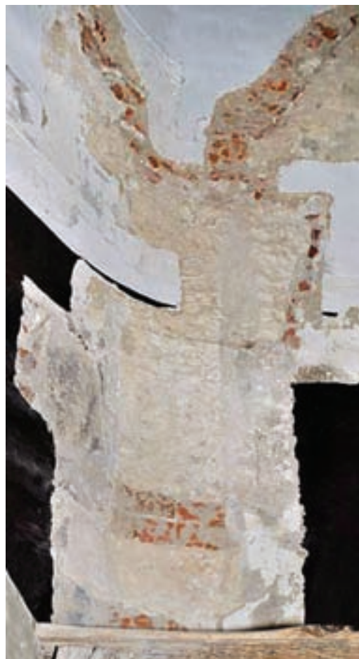
7. A XVI. század elején épült szentély boltozatának indítása
